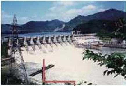
댐 기초 처리 보강
